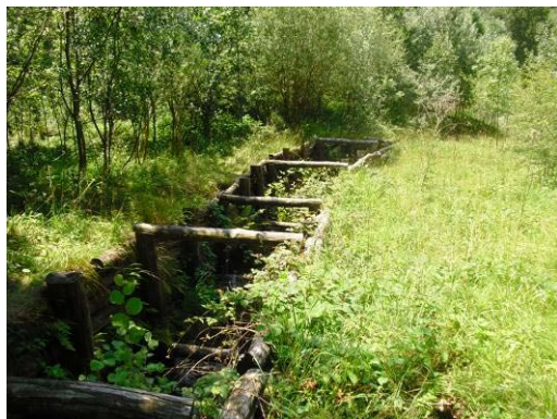
Fig 3: Vista tratto di monte
