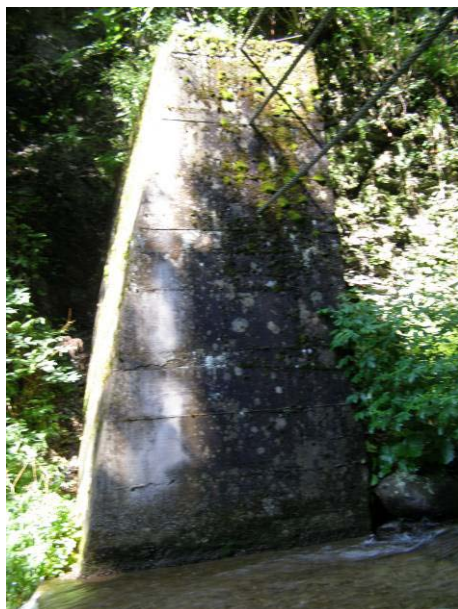
Fig 3: Vista spalla dx
