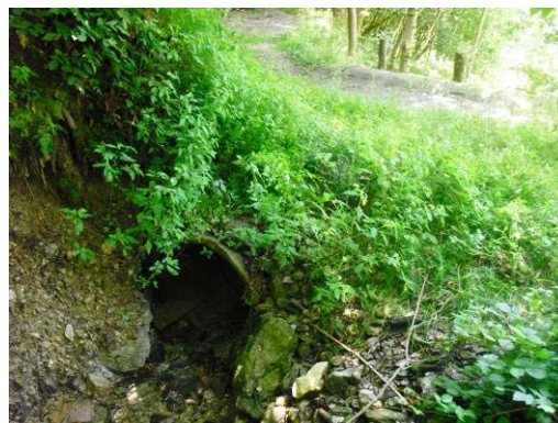
Fig 2: Imbocco di monte e strada sovrastante
