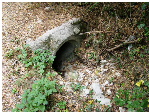
Fig.3: Vista dell'imbocco di monte
