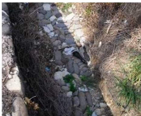
Fig.5: Particolare alveo rivestito
