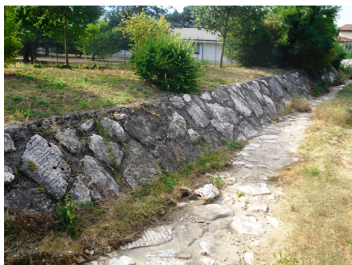
Fig.3: Sviluppo della scogliera lungo l'alveo in sx idrografica
