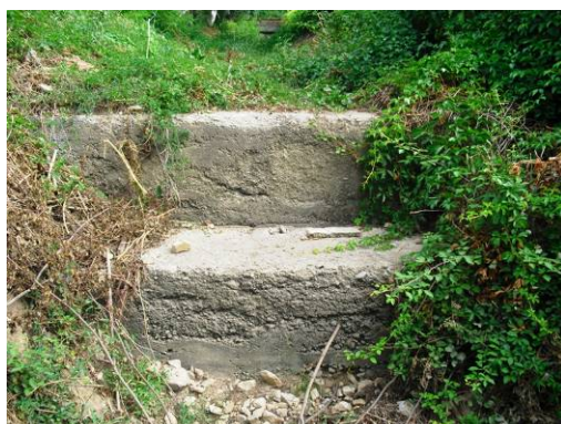
Fig.1: Vista frontale da valle
