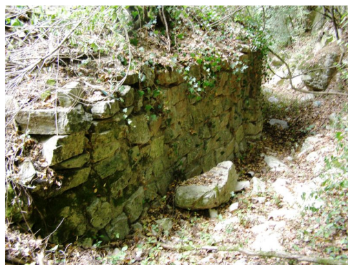
Fig.4: Vista semi-frontale del muro d'argine
