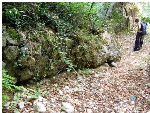
Fig.3: Vista semi-frontale dei gabbioni da valle verso monte
