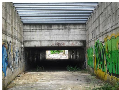
Fig.4: Vista del tratto con al di sopra la griglia
