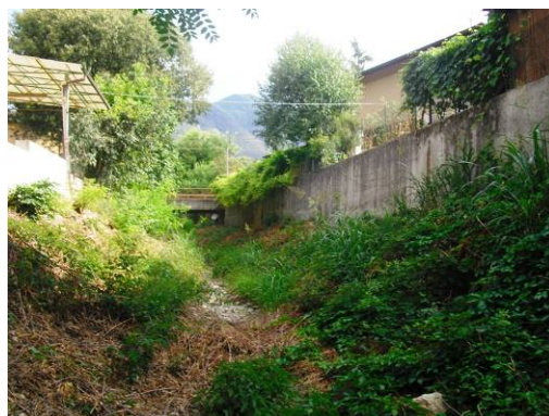
Fig.8: Tratto di muro in sx idrografica
