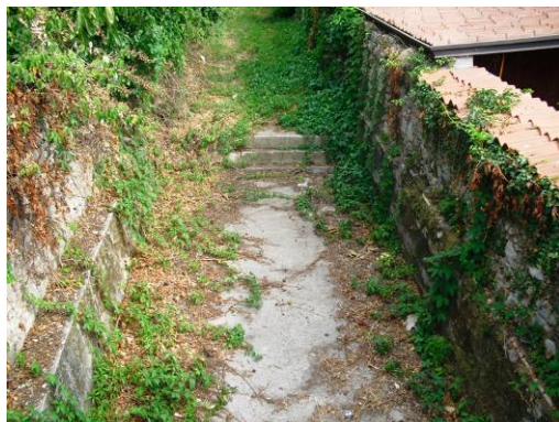
Fig.3: Vista d'insieme dei muri d'argine verso monte, dal ponte pedonale TRC09
