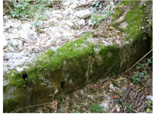
Fig.4: Particolare della gaveta erosa da dx idrografica
