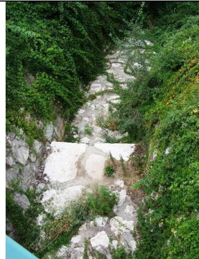
Fig.4: Vista dal ponte verso valle
