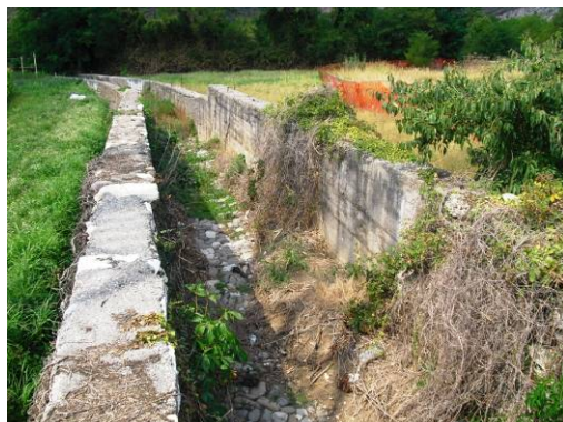
Fig.3: Vista verso valle
