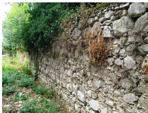
Fig.4: Tratto di muro in dx idrografica
