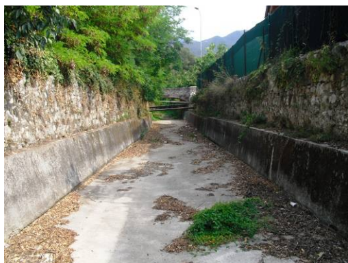
Fig.3: Vista d'insieme da valle verso monte
