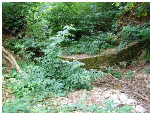
Fig.1: Vista frontale da valle
