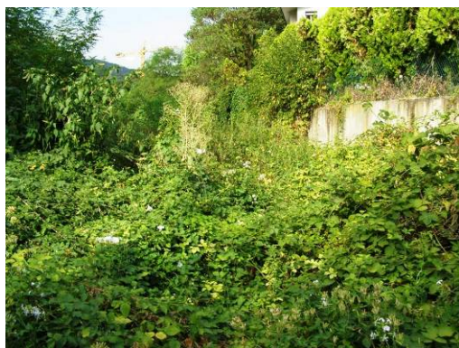
Fig.3: Vista d'insieme da valle verso monte
