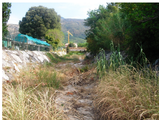
Fig.6: Vista d'insieme da valle verso monte
