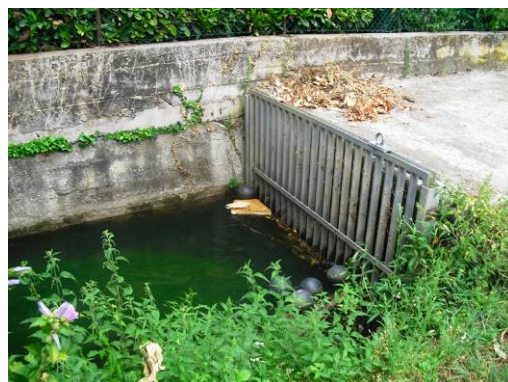
Fig.4: Vista delle griglie da pulire a monte del tombinamento di codice CEL011
