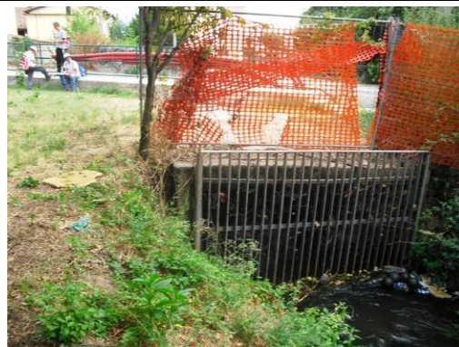
Fig.4: Vista delle griglie da pulire a monte del tombinamento di codice CEL011
