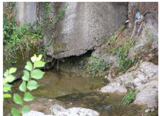
**Fig 2: Particolare erosione di spalla**
