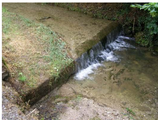
Fig 1: Vista da valle
