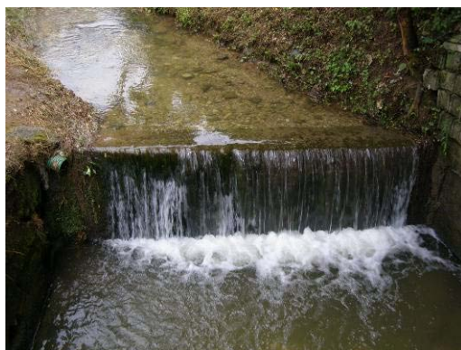
Fig 1: Vista da valle
