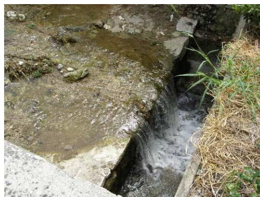
Fig 2: Vista da valle
