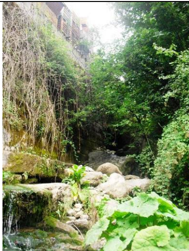
Fig.1: Vista del muro d'argine VRE001 in sx e dell'alveo da sfalciare
