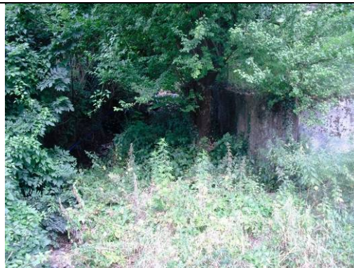
Fig.5: Vista dell'alveo da sfalciare a ridosso del muro VRE004 da ripristinare
