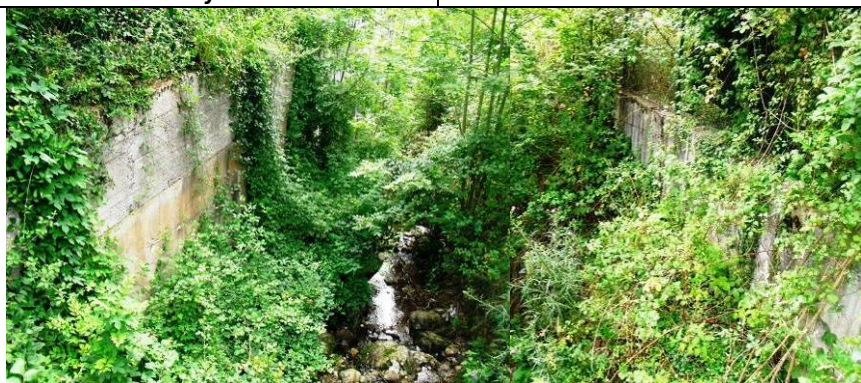
Fig.3: Vista della vegetazione in alveo da rimuovere
