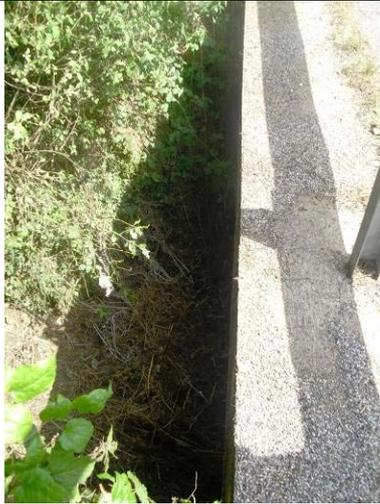
***Fig.3: Particolare dell'attraversamento a monte, completamente intasato dalla vegetazione***
