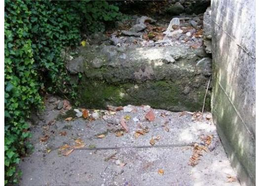
**Fig.4: Vista frontale di una delle soglie parzialmente erose contenute nel tratto d'alveo canalizzato PA2002 da rifare**
