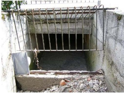
**Fig.1: Vista dell'imbocco di monte del tombinamento PA2001 e della griglia selettiva da sistemare**
