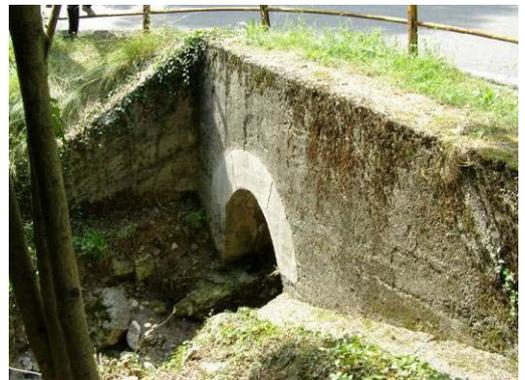
**Fig.6: Vista del ponte PA2007 con spalle e fondo alveo erosi da consolidare/rifare**
