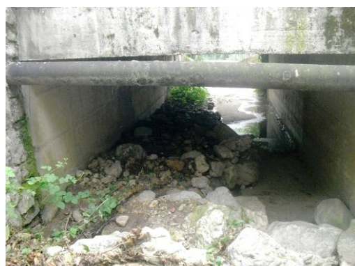
Fig.2: Vista del materiale da asportare al di sotto del ponte di codice PA1006
