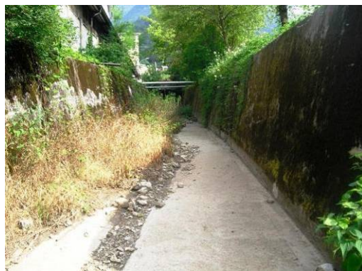
Fig.1: Vista del tratto d'alveo canalizzato PA1001 da pulire/svasare/sfalciare
