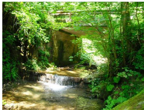
Fig.4: Vista dell'alveo in corrispondenza del ponte di codice IRM022
