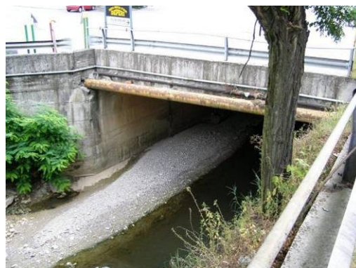
Fig.4: Uscita del tombinamento GOB039
