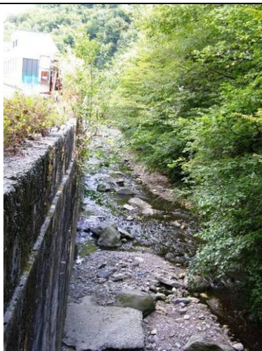
Fig.7: Tratto d'alveo con muro d'argine in dx di codice GOB056
