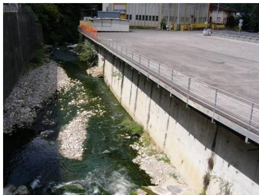
Fig.3: Tratto relativo al muro d'argine in dx di codice GOB032
