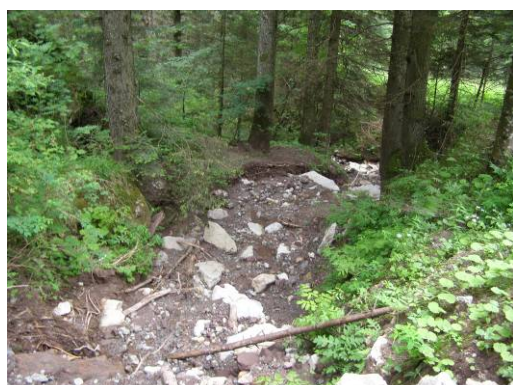
Fig 7: Alveo interessato dalla colata
