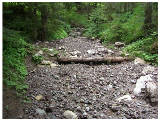
Fig 6: Alveo interessato dalla colata
